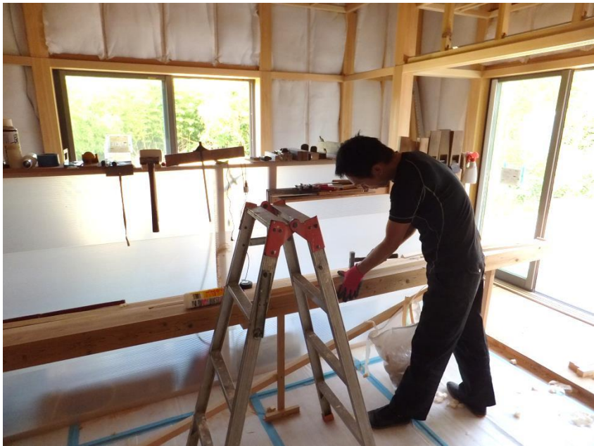
写真は淡路島で建築中の土佐材を使用した新築住宅
