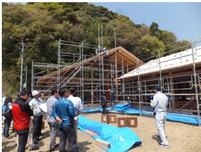
韓国企業 7 社 10 人が土佐派の家建築現場を見学しました。(26/04/17)
