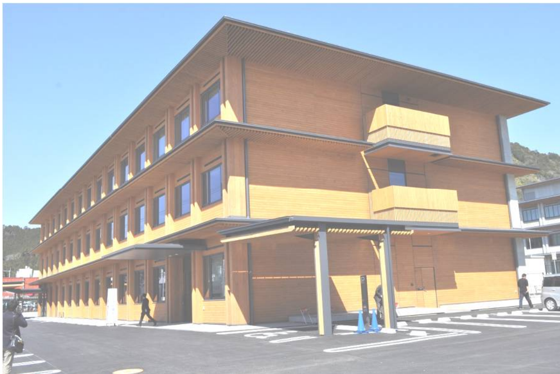
四万十町本庁舎、RC・鉄骨・木の混構造
